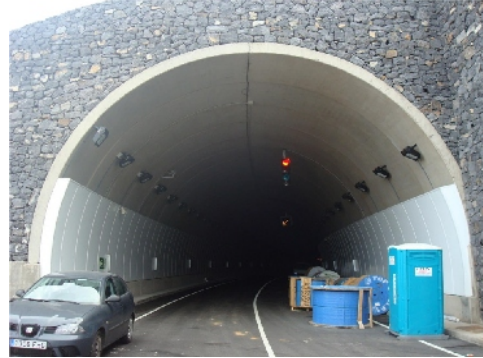
Túnel el Guincho, Tenerife
