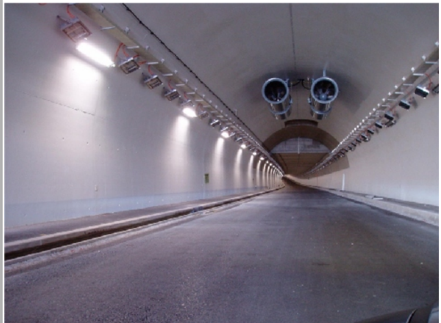
Tunnel de Bulle
